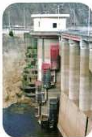
取水ゲート 農業・工業共に独立した7門のゲートがあり、農業は水面近くの暖かい水、工業は水深の深い冷たい水を取水する。
