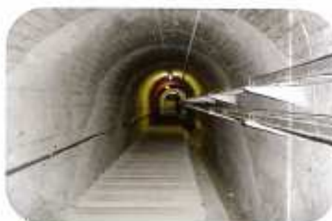
監査廊 ダム堤体に点検用のトンネルがあり、漏水点検などを実施している。
