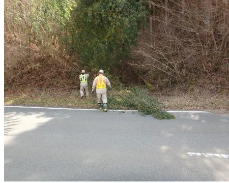
支障木撤去作業
