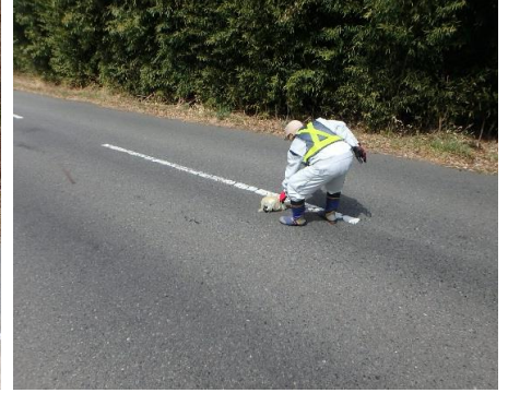
落下物撤去作業
