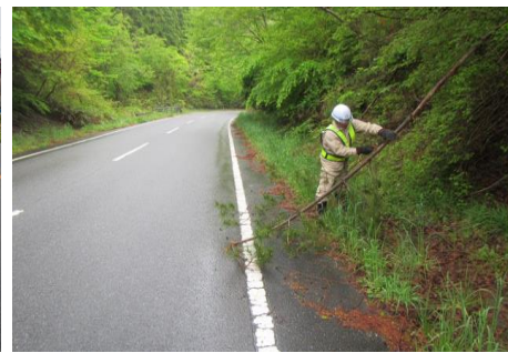
支障木撤去作業
