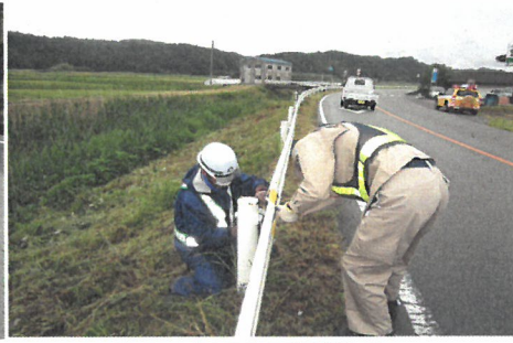
応急補修作業
