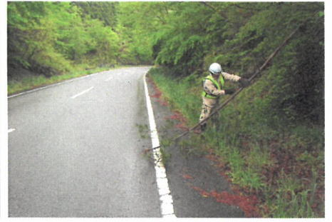
支障木撤去作業
