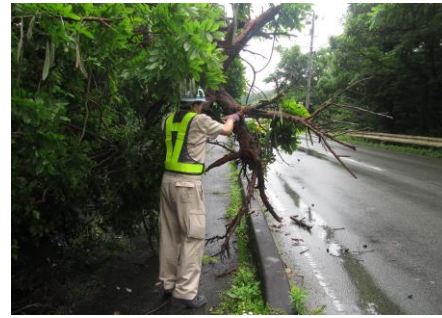
支障木撤去作業
