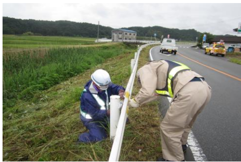
応急補修作業
