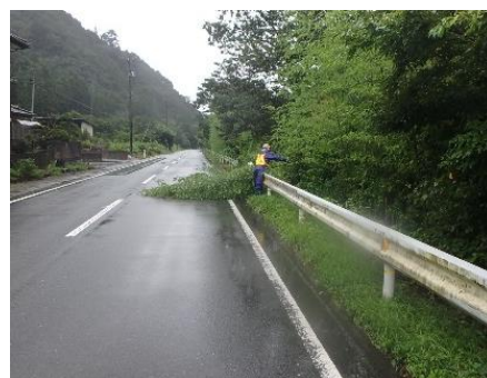
支障木撤去作業
