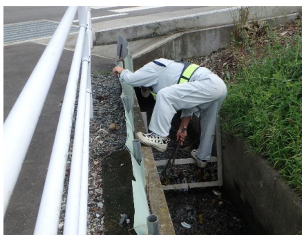
側溝清掃作業
