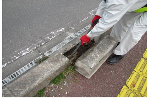
道路施設補修作業
