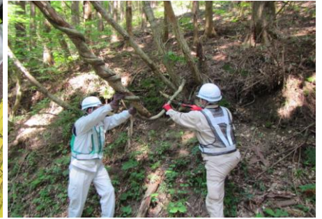
支障木撤去作業
