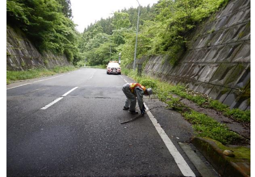
落下物撤去作業
