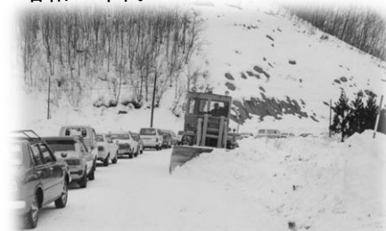
道路除雪作業の様子
