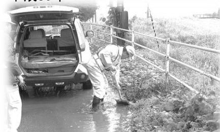
道路補修作業の様子
