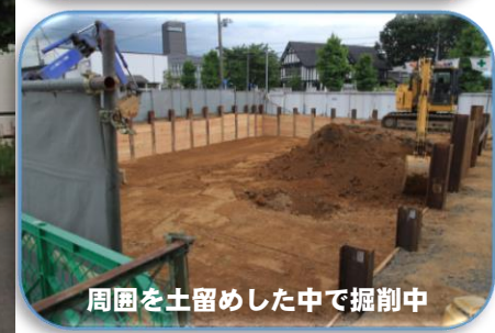
掘削工事の様子
