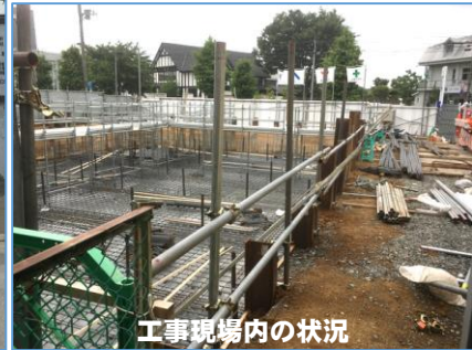
鉄筋組立作業の様子
