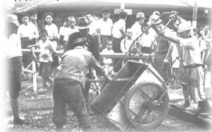
須賀川市内における舗装工事の様子
