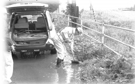
道路補修作業の様子
