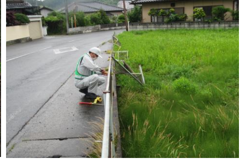
道路施設応急処置
