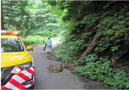
落下物撤去作業
