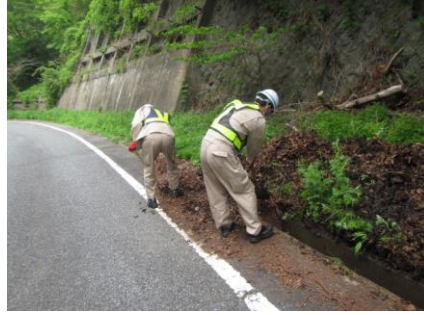
側溝清掃作業
