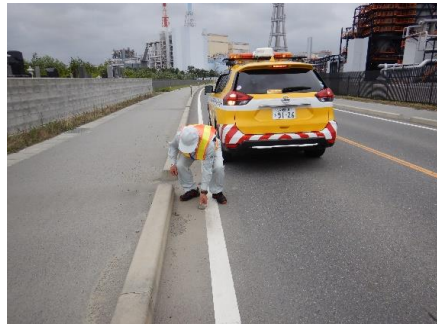
落下物撤去作業
