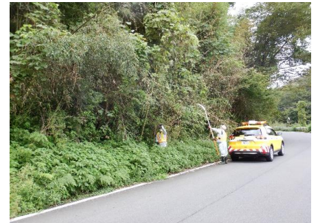
支障木撤去作業
