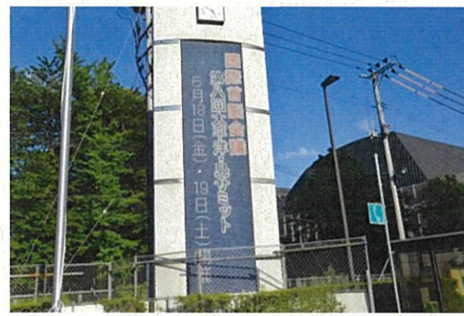
いわき市役所 多目的大型表示盤
