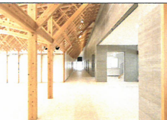
＜内装の木質化＞
