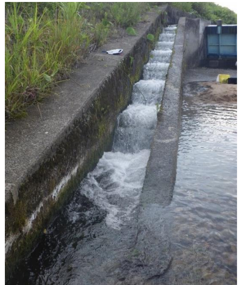
図 2 魚道の構造
