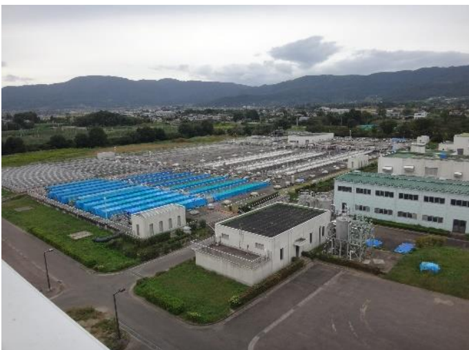
県北浄化センター全景
