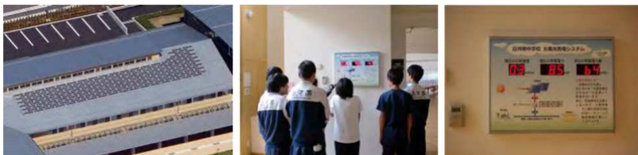
図.2-13 太陽光発電・雨水利用設備の見える化(福島県白河市立南中学校)
