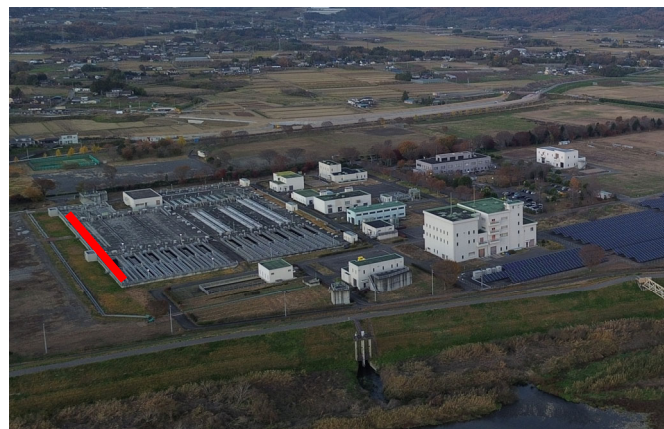
2系列6池 電気・機械設備新設
