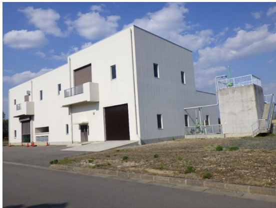
耐水化(第2SP棟)
