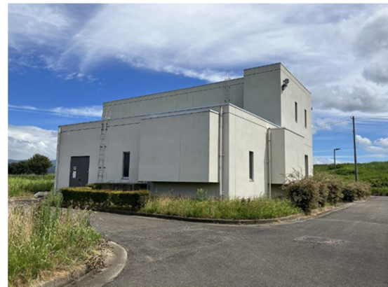
耐水化(放流ポンプ棟)
