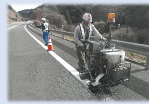
施工中の状況
