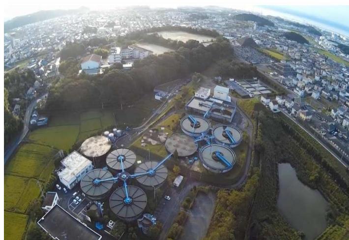
泉浄水場全景
