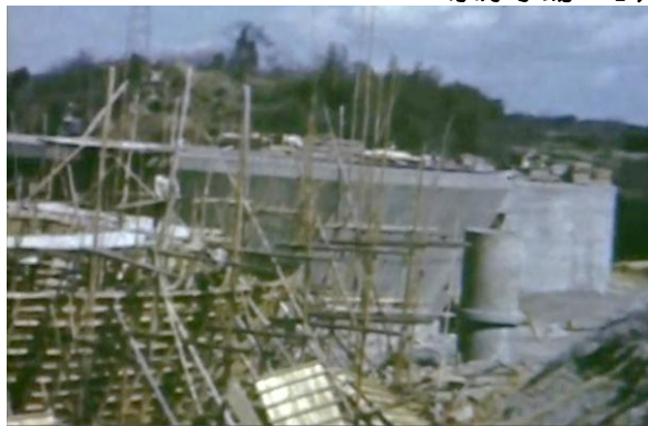
建設時（昭和 37 年度） 竹で足場で組む様子
