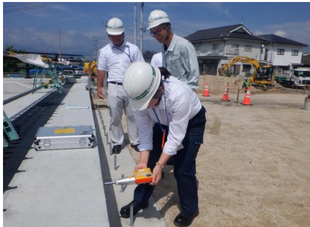
コンクリートの強度確認
